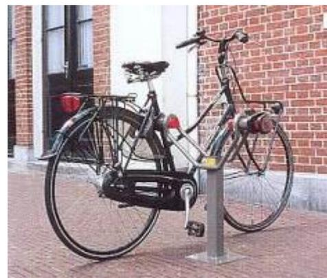
Ce type de modèle ne convient pas non plus aux chaînes et aux cadenas de type bao. Les cyclistes sont obligés de s'accrocher au support en dehors du dispositif d'accroche et le vélo n'est pas stable pour autant.
