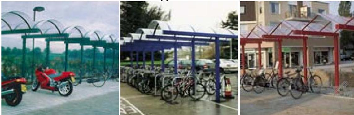
Toit soutenu avec des pieds que d'un côté => d'avantage de possibilité de manœuvre
